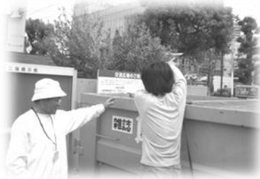
コンテナ投入
